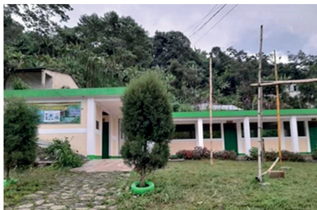
Ilustración 54: Instalaciones de la Telesecundaria de la Aldea Loma Linda (W. Mazariegos, 2024).
