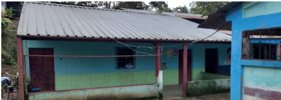
Ilustración 92: Construcción destinada para ser el área de salud (W. Mazariegos, 2024).
