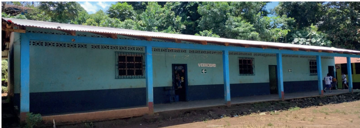
Ilustración 91: Escuela del parcelamiento El Tineco (W. Mazariegos, 2024).
