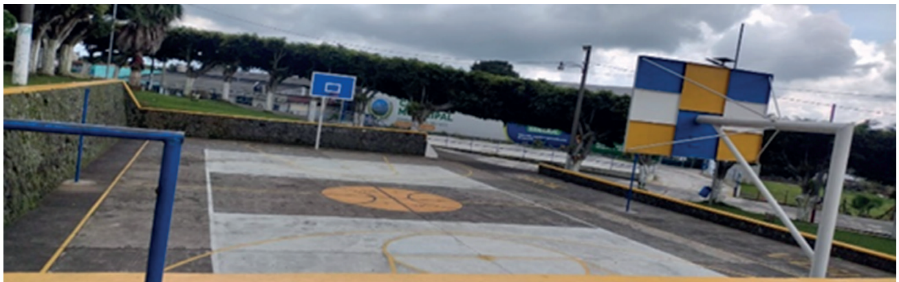
Ilustración 36: Canchas deportivas ubicadas en el parque central (W. Mazariegos, 2024).
