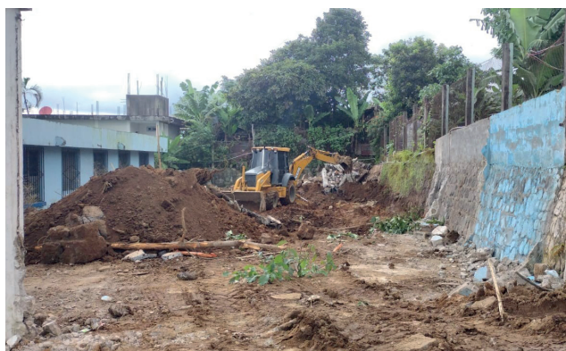
Ilustración 41: Inicio de construcción del área de encamamiento y partos del CAP (W. Mazariegos, 2024).
