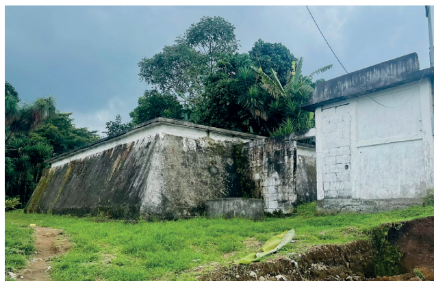
Ilustración 40: Tanques de distribución de agua (W. Mazariegos, 2024).
