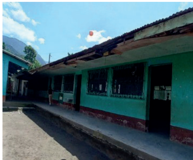
Ilustración 53: Instalaciones de la Escuela Oficial Rural Mixta de la Aldea Loma Linda (W. Mazariegos, 2024).
